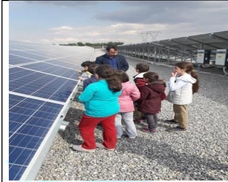
Güneş enerji santralinde incelemelerde bulunduk.
