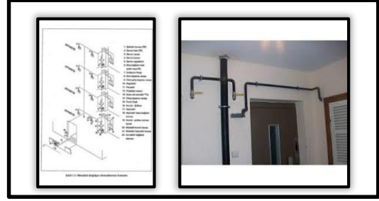
Şekil (2) Bina içi kolon tesisatı
