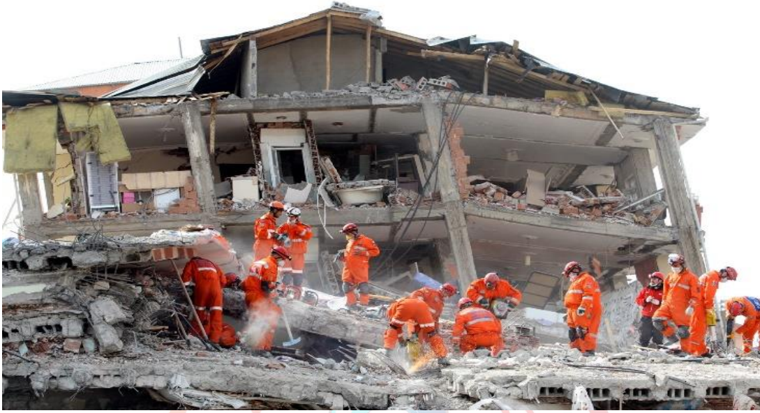
Şekil 1. Enkaz alanındaki dar ve belirsiz bölgeler
